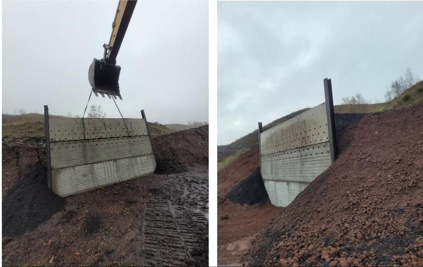
**Figure 5: Construction d'une falaise artificielle à Hironnelle de rivage dans la carrière d'exploitation à Loos-en-Gohelle**
